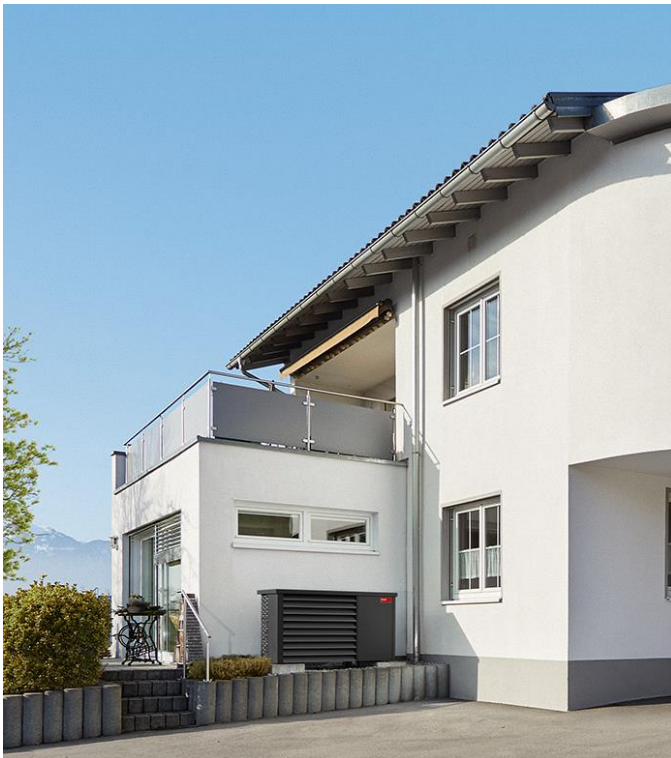
Bild 1 und 2: Luft/Wasser-Wärmepumpe mit Aussengerät 2
