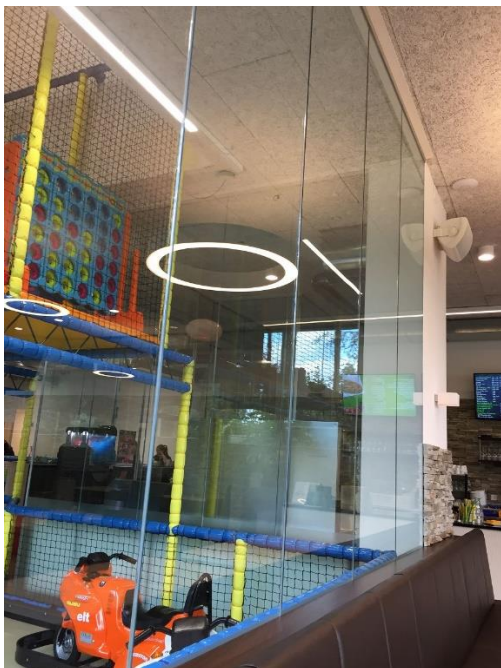
Innenverglasung als Ganzglasanlage 2
